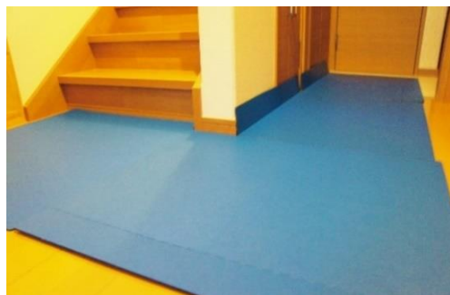
階段下周りの養生もできます
